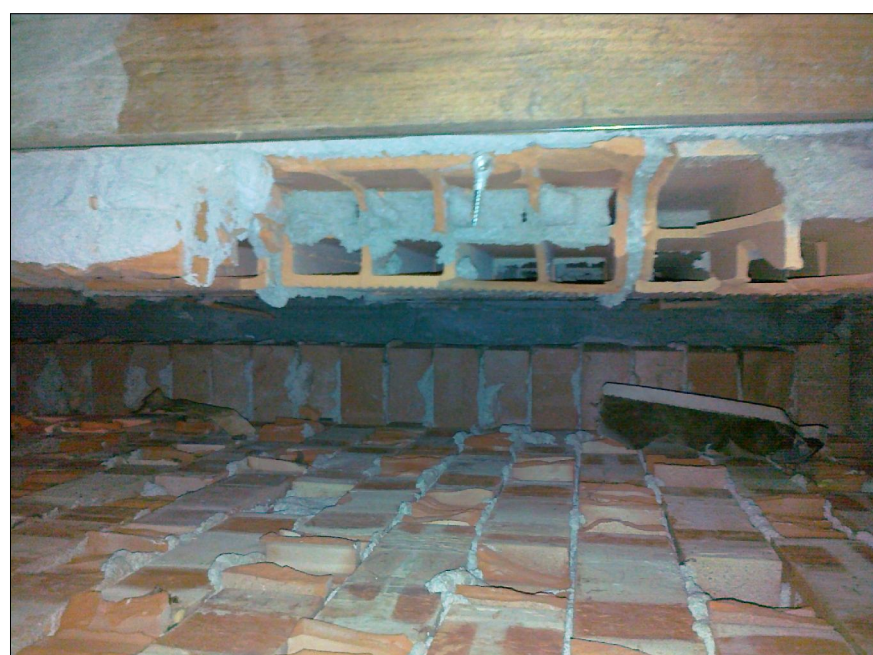
IMMAGINE DELLA MURATURA A CASSAVUOTA DA RIEMPIRE CON CELLULOSA
